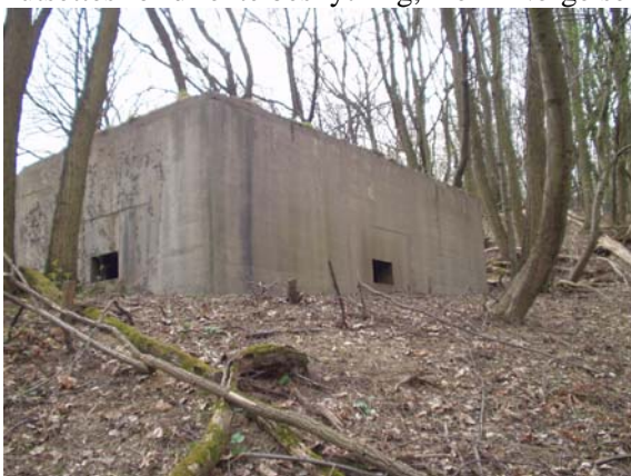
R 10 - Tidlig type Regelbau MG bunker som var delt i to. En del som kamproom og en del som gasstett mannskapsrom. for å betjene MG måtte man ut av bunkeren og inn naboøra, da det ikke var innvendig forbindelse! Bilde av Erik Eittrup
