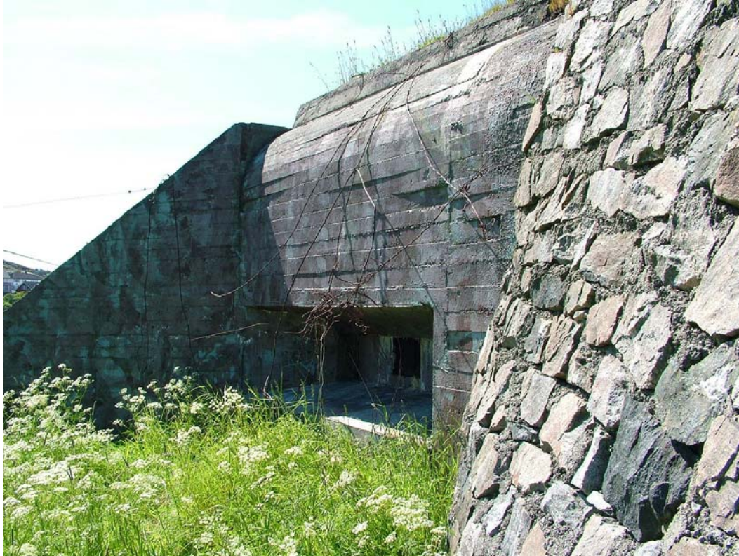
R105 Neu Videreutvikling med forsterket front og tredobbel panserplate som ble bygget i Norge. Før 600 serien trådte i kraft i 42-43 ble det planlagt en rekke R 105 neu Norge. Fra 1943 tok R 630 over for R 105. Bilde av Erik Ettrup
