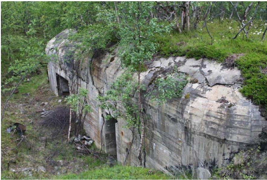
R 504 Pak-Garasje og mannskapsrom bygget som en av de første Kriegersregelbauten. Nytt for disse var de typiske avrundede hjørnene. Denne bunkeren ble i 1942-43 erstattet av R 629. Bilde av Erik Ettrup
