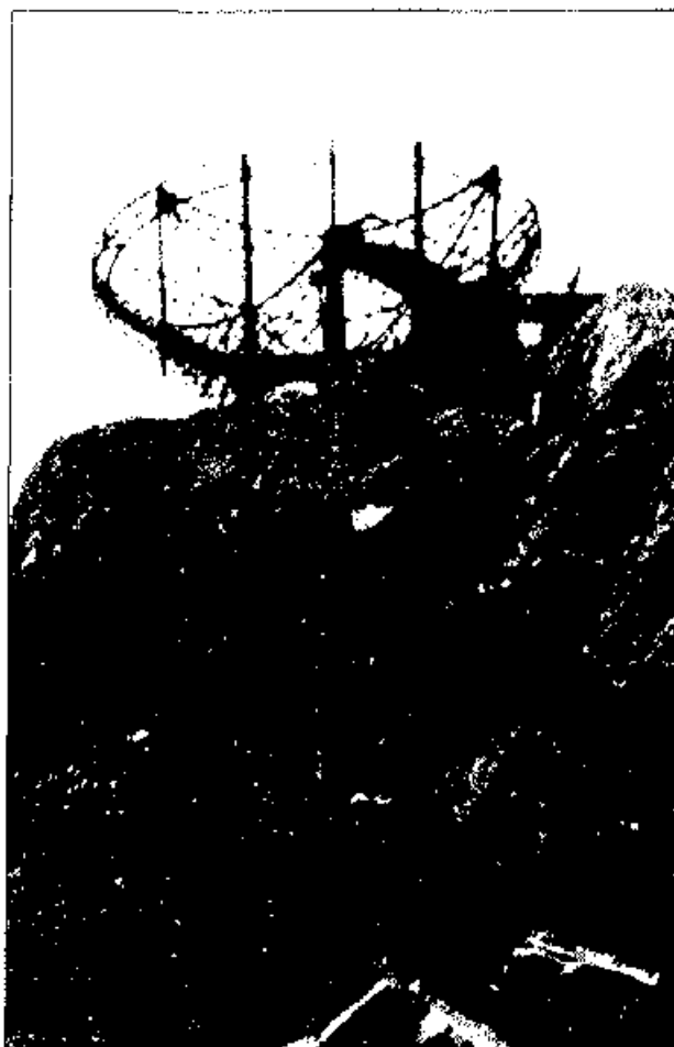
En Würzburg-Riese (FuMO 214). Den var mye brukt som artilleriradar av tyskerne. Her står antennen i hvilestilling.
