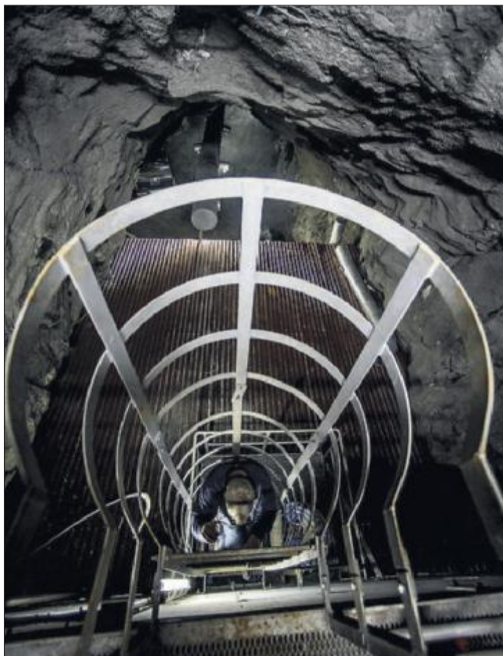
VANNSORSYNING. Det finnes også tunneler av nyere dato i Aksla. Som her, i anlegget som forsyner deler av sentrum med drikkevann.
