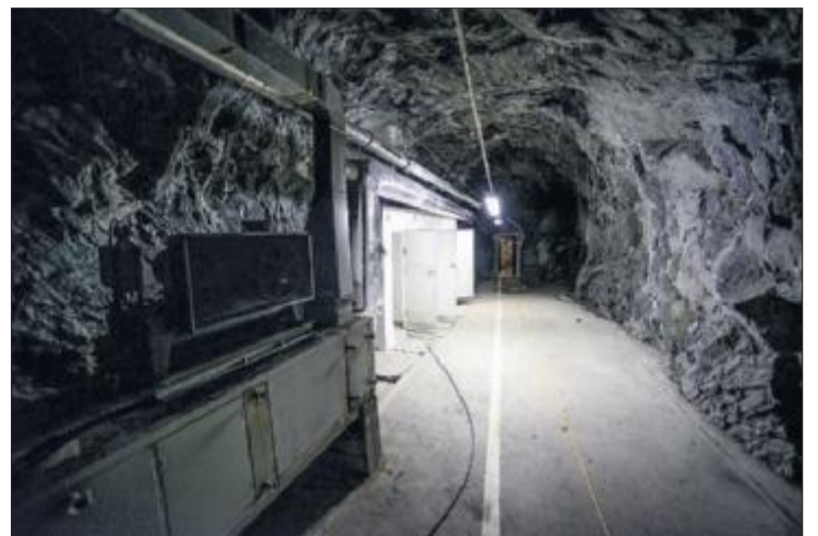
INNHALDSRIKT. Anlegget i Aksla, som ble bygget av sovjetiske krigsfanger og tyske ingeniører, er svært omfangsrikt.
